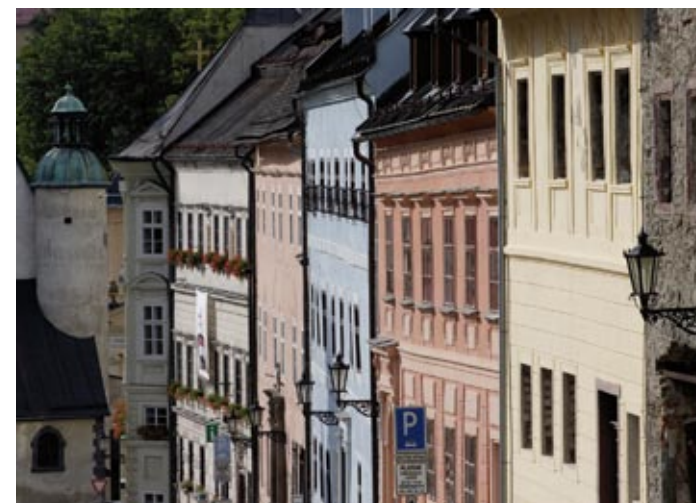
Opravené fasády renesančních paláců
